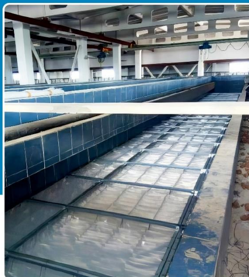
Тонкослойные модули из полиэтиленовой пленки, установленные в горизонтальном отстойнике (в процессе строительства)
